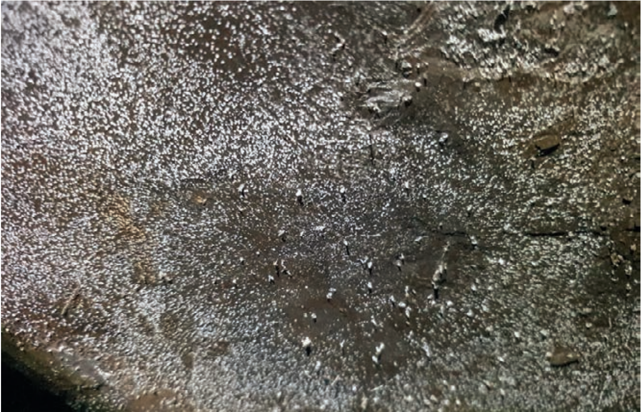
Abb. 9: Feinkristalline Gipsausblühungen auf Tonstein im ehemaligen Abbaubereich der Grube "An der Pfarrwiese" bei Reiffelbach (Foto: G. WIEBER)
